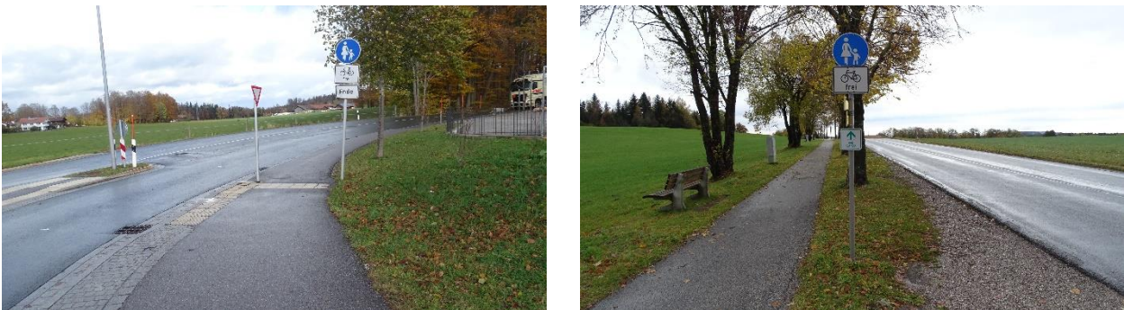
Abbildung 18: Entspricht nicht den Anforderungen an qualitativ hochwertige Radverkehrsanlagen: Die Führung über einen Gehweg, Radfahrer frei (straßenbegleitend)
