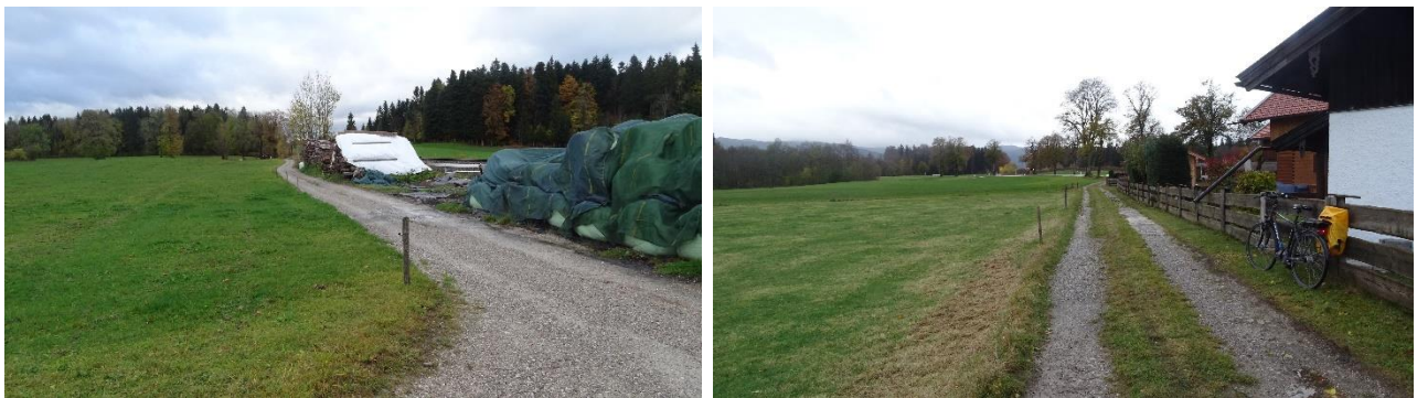
Abbildung 25: Links: Oberflächenbeschaffenheit für Basisnetz ausreichend, rechts: Oberflächenbeschaffenheit für Hauptnetz unzureichend
