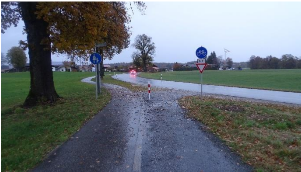
Abbildung 26: fehlende Überleitung zwischen baulichem Radweg und Führung auf der Fahrbahn (MB 6; links) und fehlende Überleitung ohne Rückenschutz am Brunnenweg (rechts)
