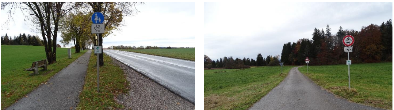
Abbildung 20: Gesicherte Abschnitte: Gehweg, Rad frei an der Mariensteiner Straße (links); Verbot für Kraftfahrzeuge, landwirtschaftlicher Verkehr frei von der B13 in Richtung Piesenkam (rechts)
